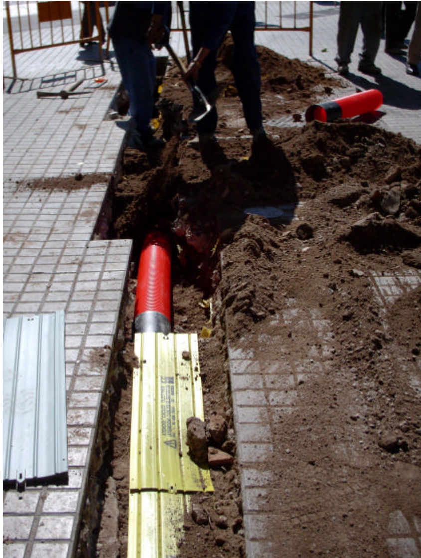
Foto. 6. Col.locació de tub.
